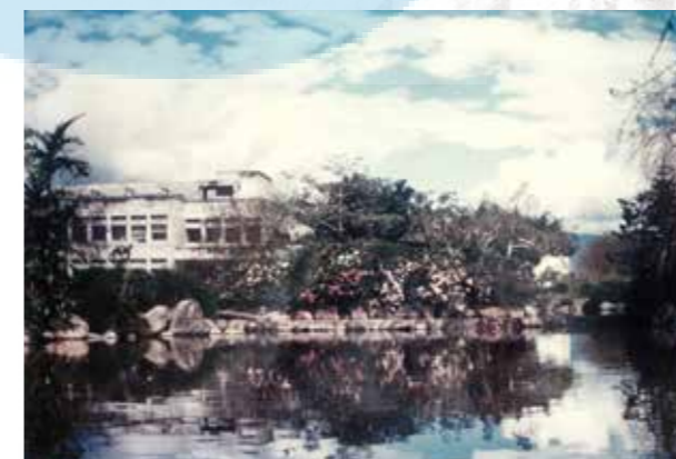
改設專科之前，系館牆面尚未貼磁磚。（摘自本校第一輯校史）
