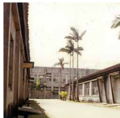
第一期工程時，部分建築只有一樓。(摘自本校第一輯校史)
