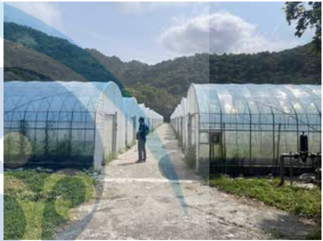
整修完成之 34 棟溫室
