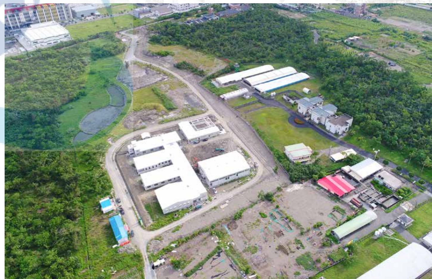
空拍圖為民國 107 年五結三生產學園區工程
