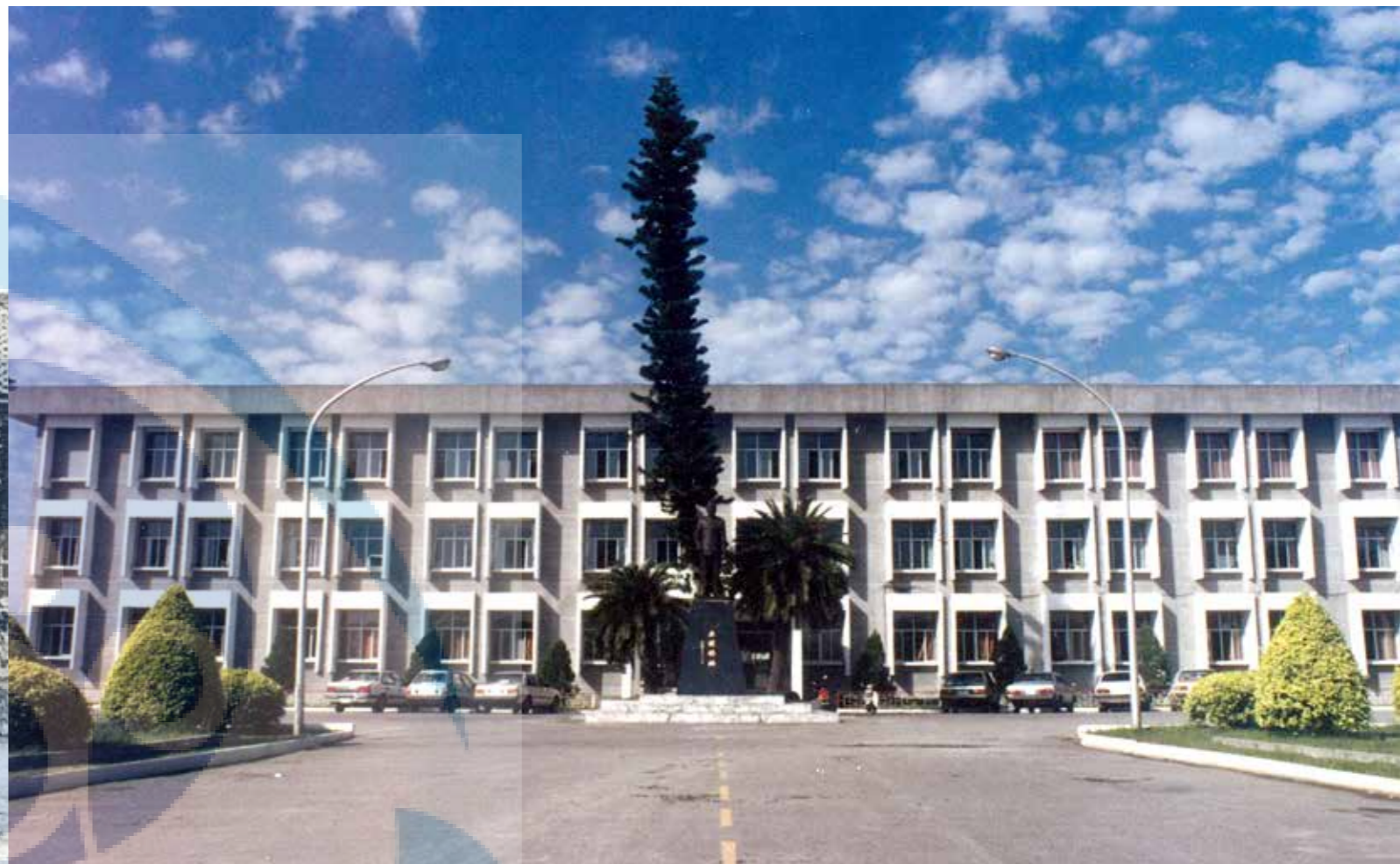
農工職校時期之行政大樓，竣工於民國 71 年 6 月，總工程費為 27,990,789 元；原兩層樓木造大樓及兩旁教室室拆除。(摘自本校第一輯校史)
