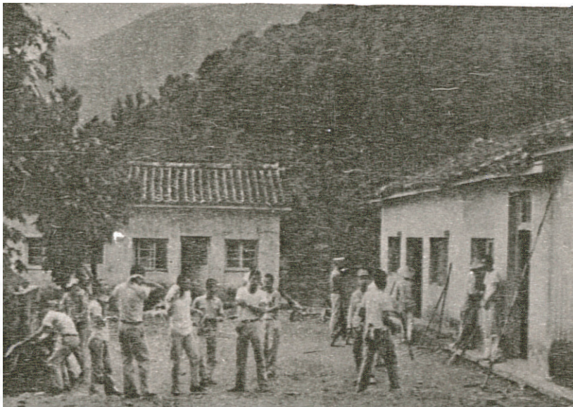
50、60 年代舊林場寢室， 正前方為廚房與浴室
