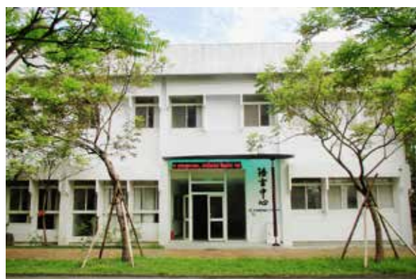
中心正面照片
