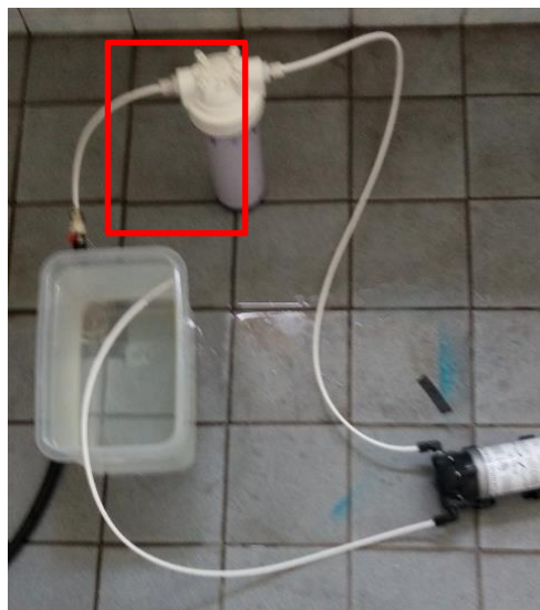
圖 13. 獨立第一道濾心之過濾設備
