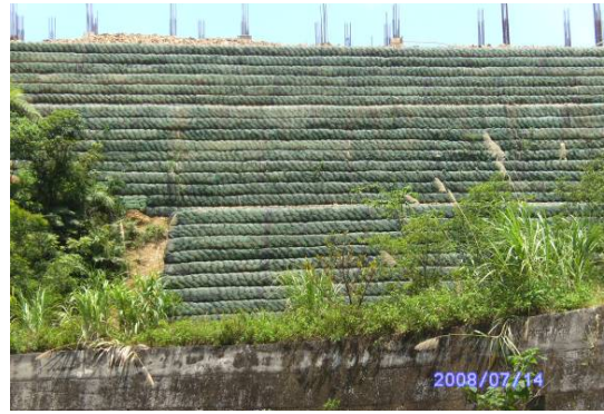
圖 6 喜來登宜蘭渡假酒店之加勁擋土結構現況圖 (From 王宏相, 2008)
