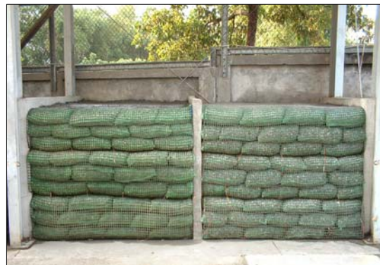
圖 4 宜大加勁擋土牆現場實景
